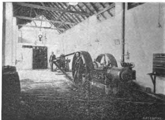
FIG. 2.—FORT WAYNE STATION, BARRANQUILLA, U. S. C.
